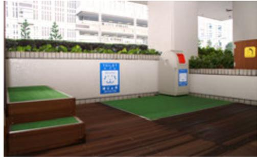
平らな床面をもつ南館ロビー外側の屋根のある場所に設置した専用トイレは、車椅子の取り回しがしやすく、別名アイアンウッドとも呼ばれる耐久性に優れている木材ウリンを使用したウッドデッキと犬の足にもやさしい素材の人工芝を採用。人工芝の下にステンレスパンを配すことで小便がそのまま排水されるしくみになっているほか、車椅子ユーザーが後片付けをしやすくように床面より高い位置に設置した排泄用の段や、動線上の床面に配した点字ブロックなど、ユーザーにも犬にもやさしく使いやすい仕様が、導入から14年を経た今も大きな反響をいただいています。
